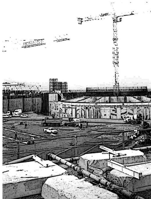
**Abb. 3. Bau einer Pfeilerbasis im Trockendock**
